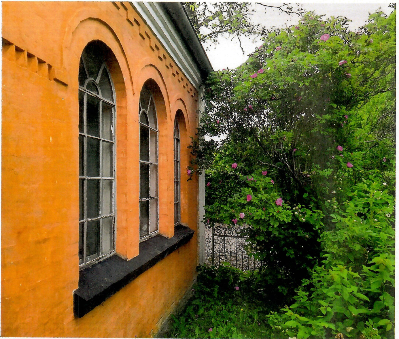
Transformeret Elværk, Gummerup, Vestfyn. Foto: Fay Kirsten Mitchell Nielsen.
